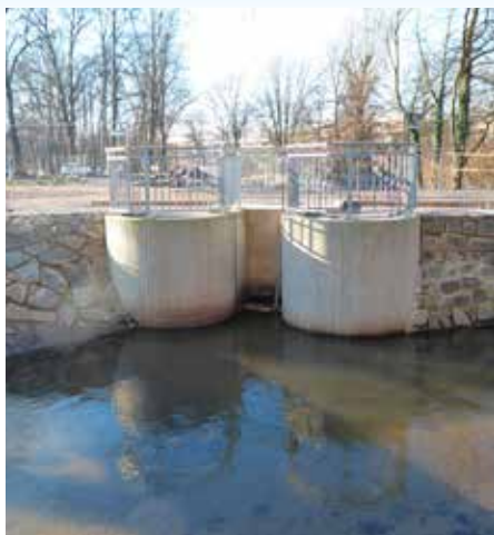
Das neue Bauwerk zur Ableitung des Wassers in die „alte Itter“ Foto: Richy Beesch
