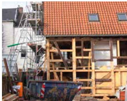
Standsicherheit des Skeletts wurde wieder hergestellt Fotos: Richy Beesch
