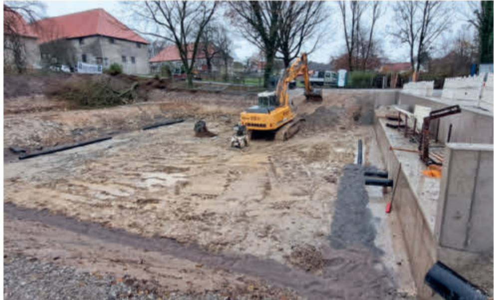
Neubau eines Retentionsbodenfilters in Rüthen-Menzel. Bild: RWG.
