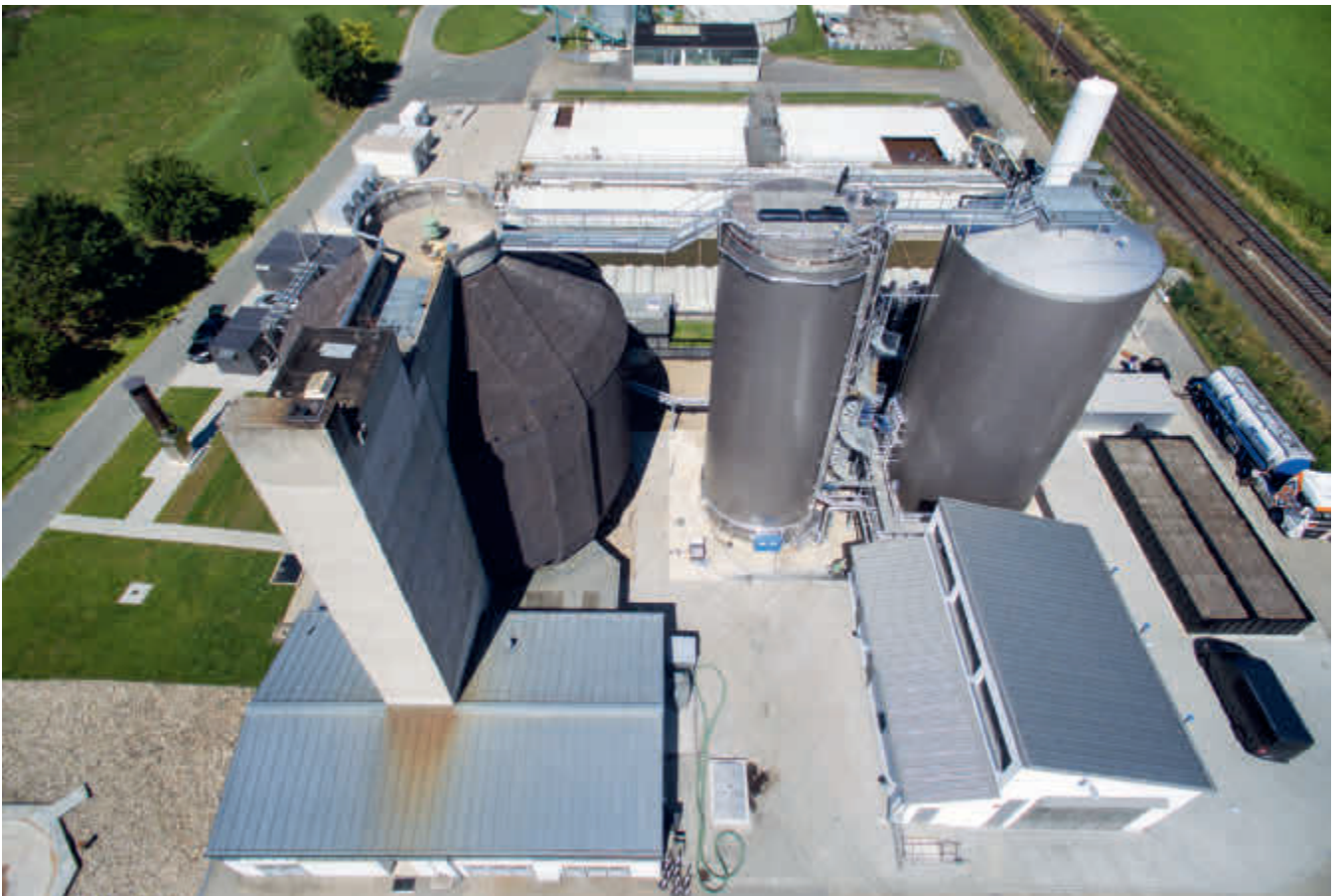
Am Faulturm der Kläranlage Warstein wurden im Jahr 2023 Schäden am Beton festgestellt. Mit der Behebung der Schäden wurde begonnen.
