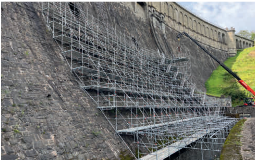
An der Ennepetalsperre hat im August 2023 die mehrjährige Sanierung der Bruchsteinmauer begonnen.
