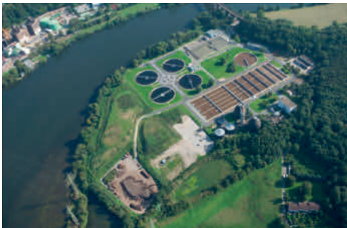
Die Kläranlage Hagen des Ruhrverbands ist Teil des abwasserbasierten SARS-CoV-2 Monitorings in NRW.
