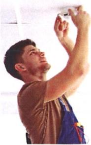
Wir haben die Firma Techem damit beauftragt, die Rauchwarnmelder in unserem Bestand auszutauschen. Die neuen Modelle arbeiten funkbasiert, was viele Vorteile mitbringt: Sie bieten im Vergleich mit herkömmlichen Meldern eine bessere Funktionskontrolle und mehr Sicherheit. Die Akkus halten bis zu zehn Jahre.
