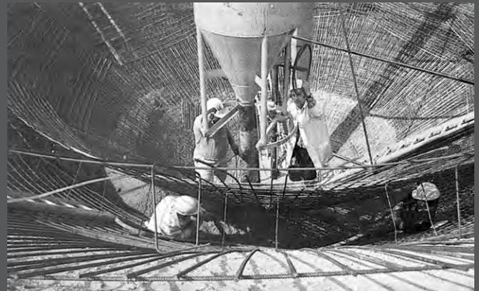
Betonieren des Faulbehältertrichters
