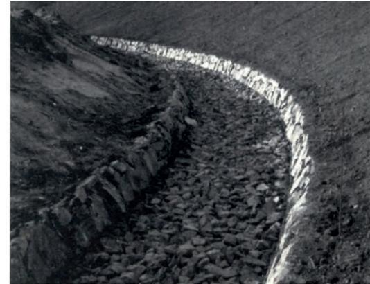
Sicherung der Sohle durch Steinwurf
