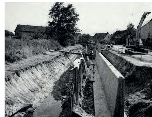
Bauabschnitt mit einseitiger Stützmauer
