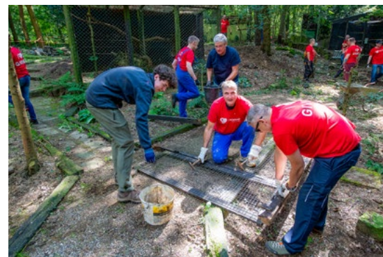
Schweißtreibender Abbruch der alten Volieren.
