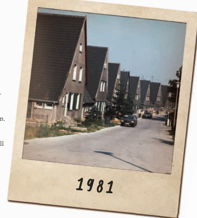
Noch weitestgehend unsaniert in den 1980er-Jahren.
