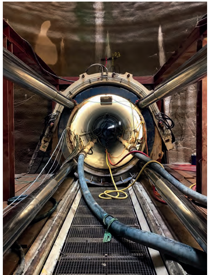
Bild oben: Rohrvortrieb | Bild unten: Entlastungsbauwerk (Notentlastung)
