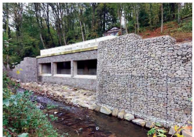
Bild oben: Rohrvortrieb | Bild unten: Entlastungsbauwerk (Notentlastung)
