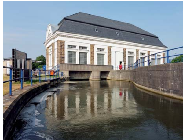
Die Wasserverteilungsanlage erhielt eine komplett neue Dacheindeckung. Auch die Fassade wurde auf Vordermann gebracht. Fotos: J. Fallmeier
