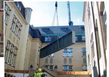
Ein Spezialkran hievte die Bauteile für die Glasdachhalle in den Gerichtsinnenhof.
