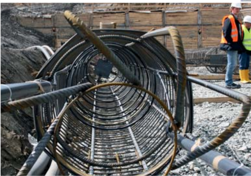
Eine Wärmequelle – zwei Konzepte: In Bielefeld fördern Sonden (Foto ganz o.) und Energiepfähle (Foto o.) die Geothermie zutage. Fotos: M. Muchow
