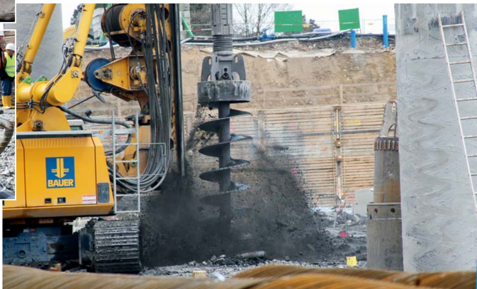
Eine Wärmequelle – zwei Konzepte: In Bielefeld fördern Sonden (Foto ganz o.) und Energiepfähle (Foto o.) die Geothermie zutage. Fotos: M. Muchow
