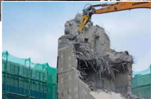
Abriss in zwei Etappen – durch „Knabber-Bagger“ (ganz o.) und konventionell (o.) Fotos: R. Pohl GmbH
