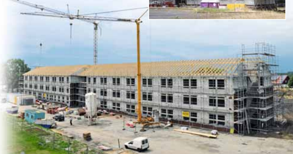
In Augustdorf wurde das Richtfest für ein neues Unterkuftsgebäude (gr. Foto) gefeiert. Und in Köln-Wahn saniert der BLB NRW Bürogebäude (kl. Foto). Fotos: C. Pilz, F. Buch
