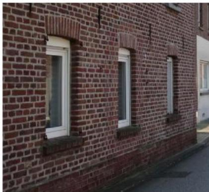
Fassadengliederung (Sturz und Sockel) durch wechselnden Mauerverband
