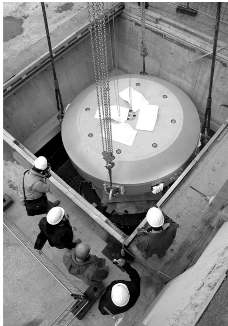
Der Protonenbeschleuniger, das Herzstück der Anlage, wurde im März mit einem Spezialkran in das Gebäude gebracht. Das so genannte Zyklotron (zwei Teile mit einem Gewicht von jeweils 120 Tonnen) hing dabei an Europas größtem mobilen Autokran.
