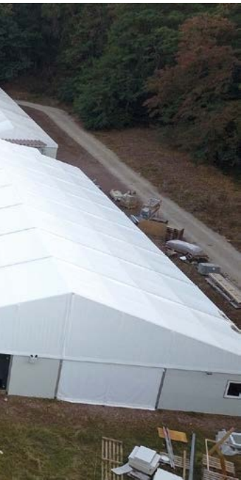
In kürzester Zeit hat die Stadt Dormagen in einer Dreifachturnhalle und einer Zeltstadt Unterbringungsmöglichkeit für ukrainische Flüchtlinge geschaffen
