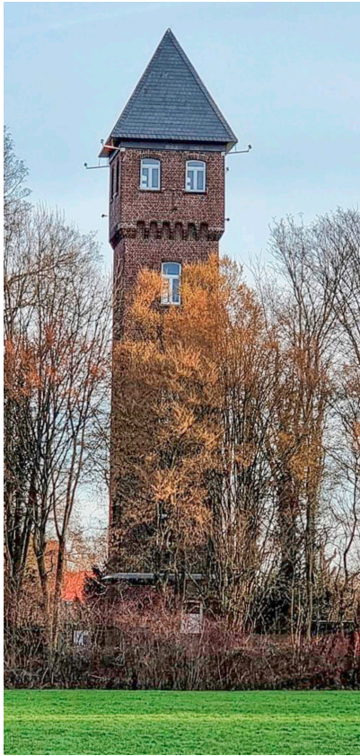
Der Wasserturm ist das heimliche Wahrzeichen von Norf. Foto: Heimatverein
