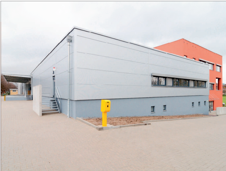
Abb. 6: Blick auf die Rückseite der Zentralapotheke mit dem für Schwerlastwagen geeigneten Rampenbereich der Warenannahme.
