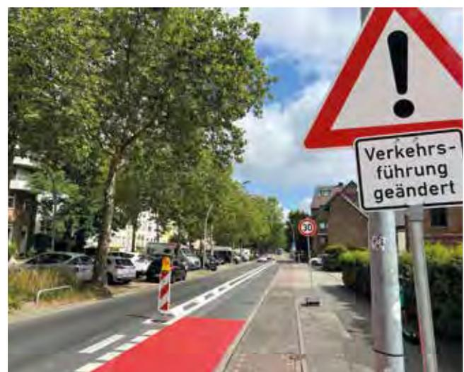
**Auf der 2,20 m breiten Fahrspur sind Radfahrende durch zwei 25 cm breite, durchgezogene Linien sowie durch Klebebordsteine vor dem motorisierten Verkehr geschützt. –**
