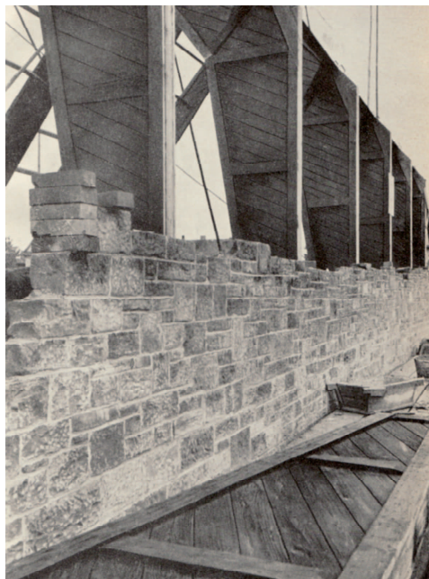
Abb. 4: Otto Bartning, Notkirche im Aufbau
