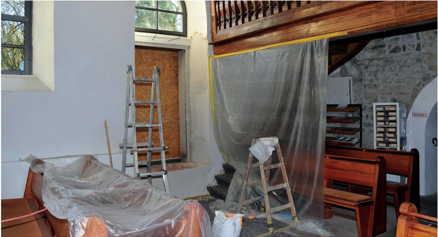
Um die Fluchttür einzubauen, wurde das bodentiefe Fenster in der Südwand gegen eine ähnliche Tür ersetzt. Auffälligkeiten wurden vermieden, auch eine Forderung des einbezogenen Denkmalschutzes. Damit wird auch der bis ca. 1970 bestehende Eingang wieder nutzbar.
