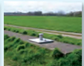
fließen, die dem Erdreich durch den Tagebau zuvor entzogen wurden. Es gibt zwei verschiedene Versickerungstypen: Schlitzte und Brunnen. Die Brunnen sind in den meisten Fällen 10 bis 30 Meter tief, können aber durchaus auch mal 150 Meter erreichen. Versickerungsschlitzte sind 40 m lang, 1 m breit und 6 m tief. Beide speisen das Ersatzwasser direkt in den sandig-kiesigen Untergrund ein.
