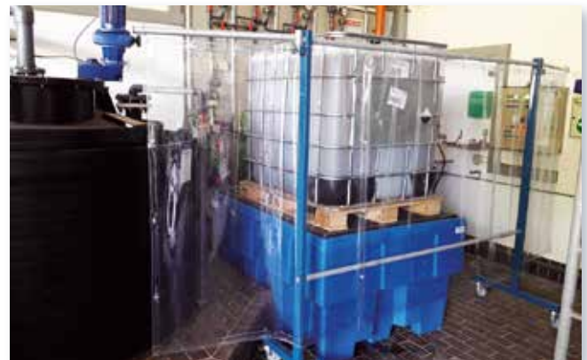
Inbetriebnahme neue Fällmittelstation im Klärwerk Monheim
