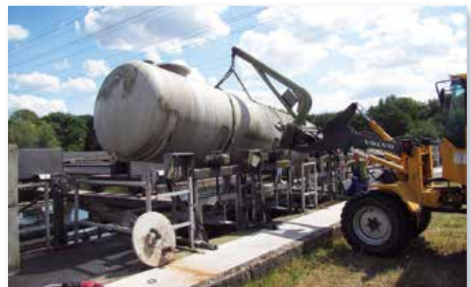
Außerbetriebnahme und Demontage Fällmitteltank Klärwerk Hilden
