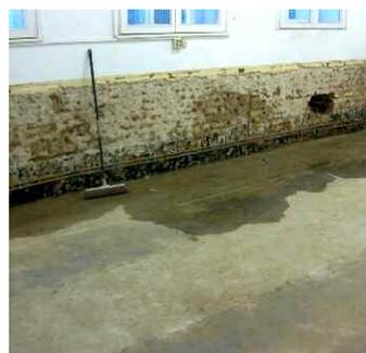
Zur Sanierung wurde in einem ersten Schritt die vorhandene alte Bodenabdichtung erneuert und das Außenmauerwerk von innen wassersperrend „imprägniert“ (hydrophobiert). Dies
