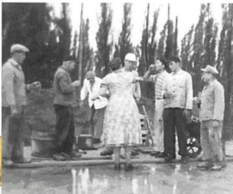
Grundsteinlegung zum Bau der Gaststätte Bienefeld
