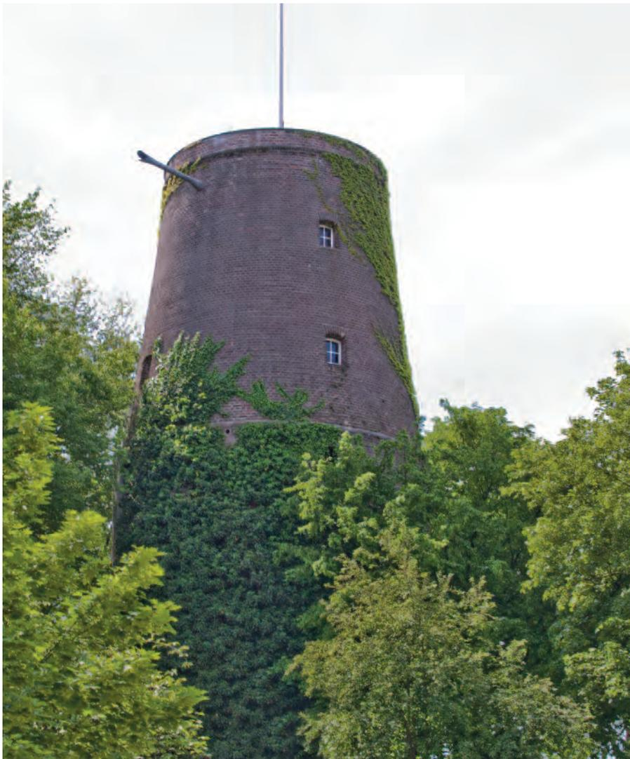
⑥ Der **Mühlenturm** ist der einzige erhalten gebliebene Teil der ehemaligen Stadtbefestigung. Seine zylindrischen Untergeschosse wurden als Geschützturm wohl 1546 erbaut. 1643 wurde er mit einem kegelförmigen Aufsatz versehen und als Mühle eingerichtet, in der bis zur Mitte des 19. Jahrhunderts Getreide gemahlen wurde.
