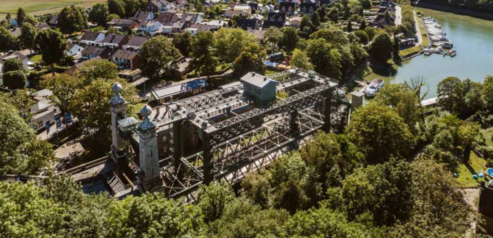
Schiffshebewerk in Waltrop. Foto: RIK/Staudinger
