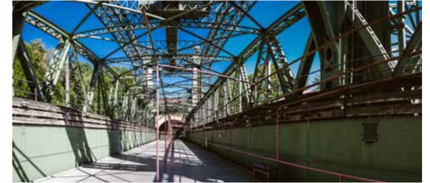
Schiffshebewerk Henrichenburg. Foto: RIK/Staudinger
