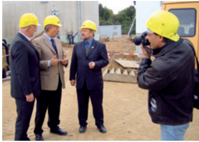
Minister Eckhard Uhlenberg (2. v. links) und Dr. Frank Michael Baumann, Geschäftsführer der EnergieAgentur.NRW (links), auf der STAWAG-Baustelle in Kerpen.
