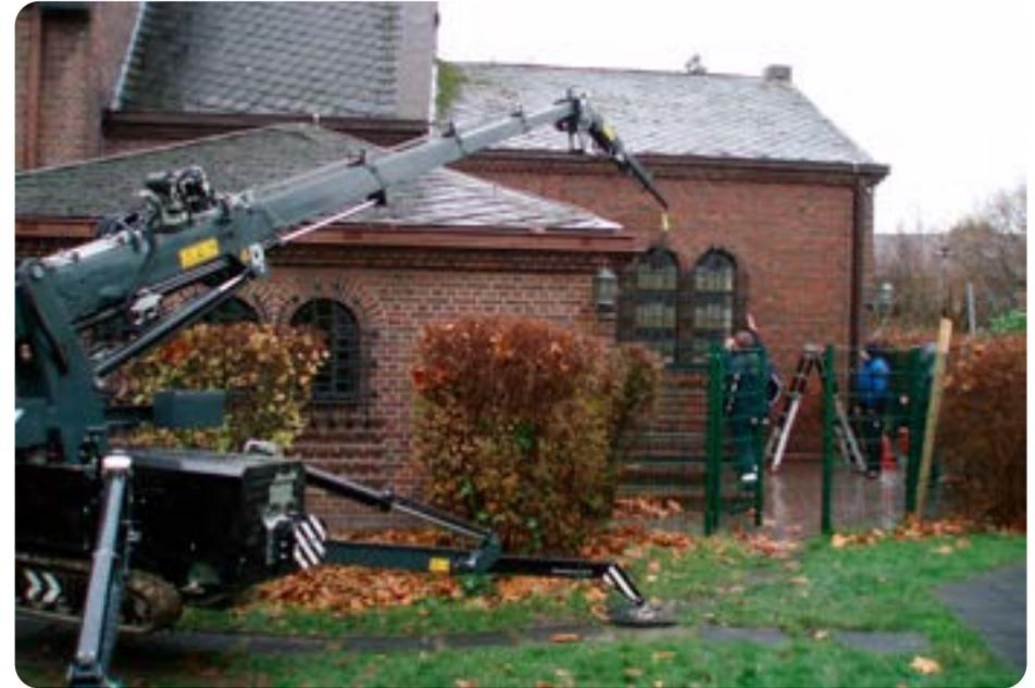
Das Foto zeigt die Montage eines der schweren Gitter mithilfe eines Krans.
