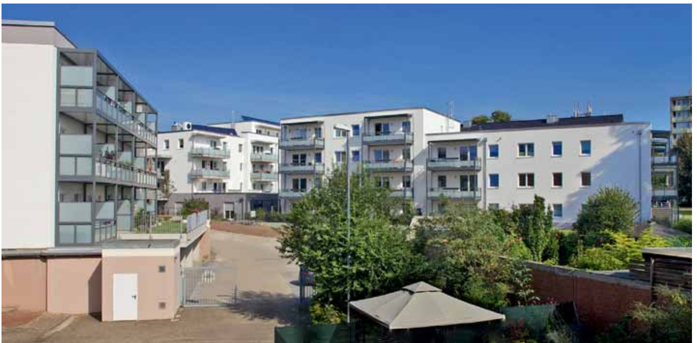
Neubau Fesserstraße 18-20a, Neuss
