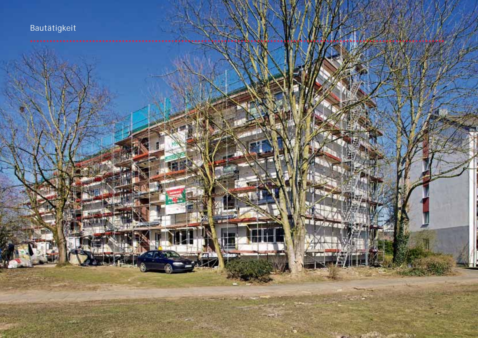
Energetische Modernisierung Weissenberger Weg 160-170, Neuss
