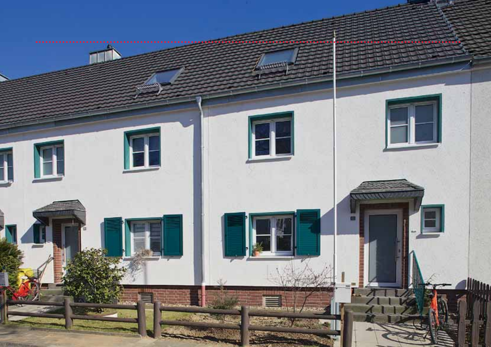
Tulpenstraße 83-85, Neuss, nach der Modernisierung
