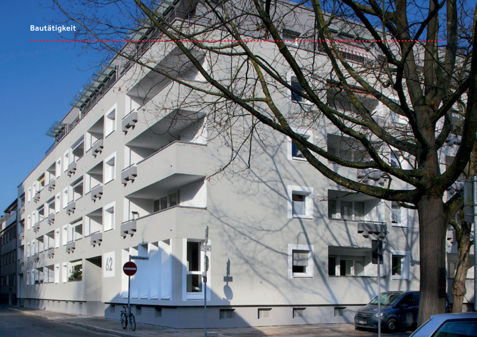
Mühlenstraße 62, Neuss, nach der Sanierung
