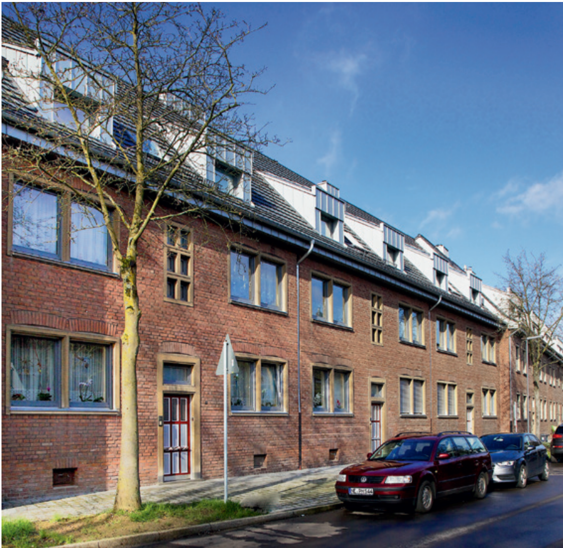
Sanierung Bismarckstraße 3-11, Neuss
