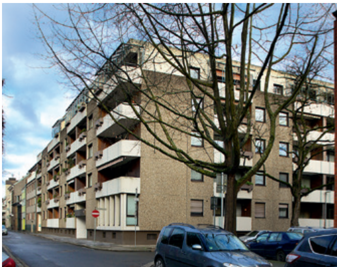
Mühlenstraße 62, Neuss, vor der Sanierung
