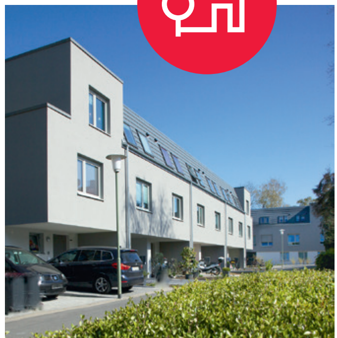
Mieteinfamilienhäuser Glehner Weg 17-17g, Neuss
