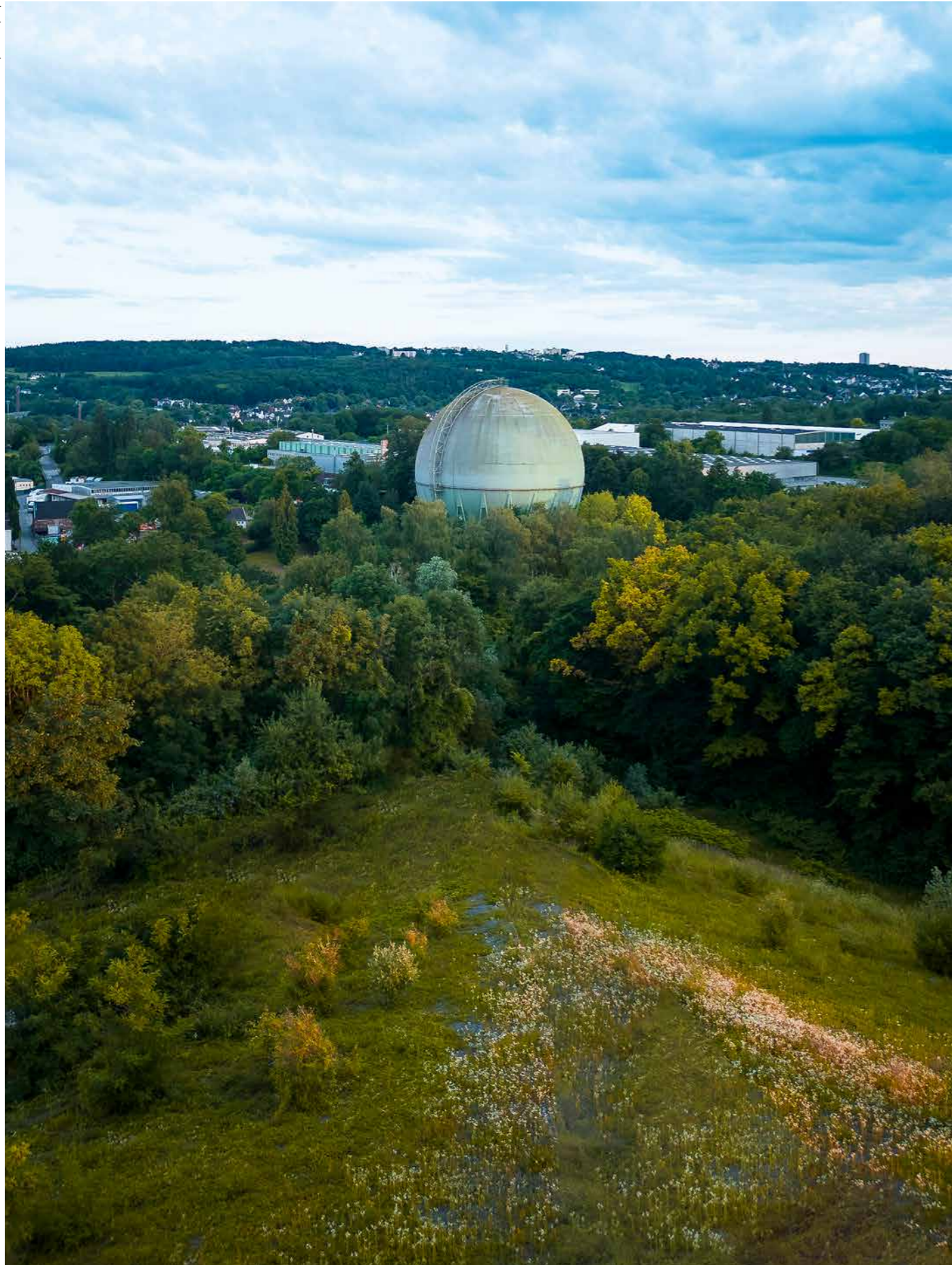
Der Wuppertaler Kugelgasbehälter – sieht mächtig aus, kann aber nur kurzfristige Versorgungsstörungen auffangen.
