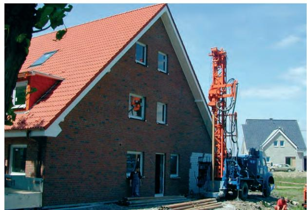
**Bild 2.2** – Geothermiebohrung
