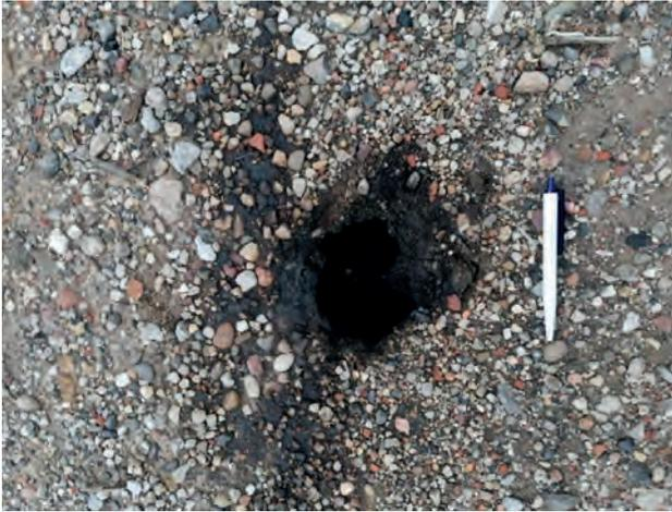
**Bild 9.6** – Risse/Löcher in der Haldenoberfläche
