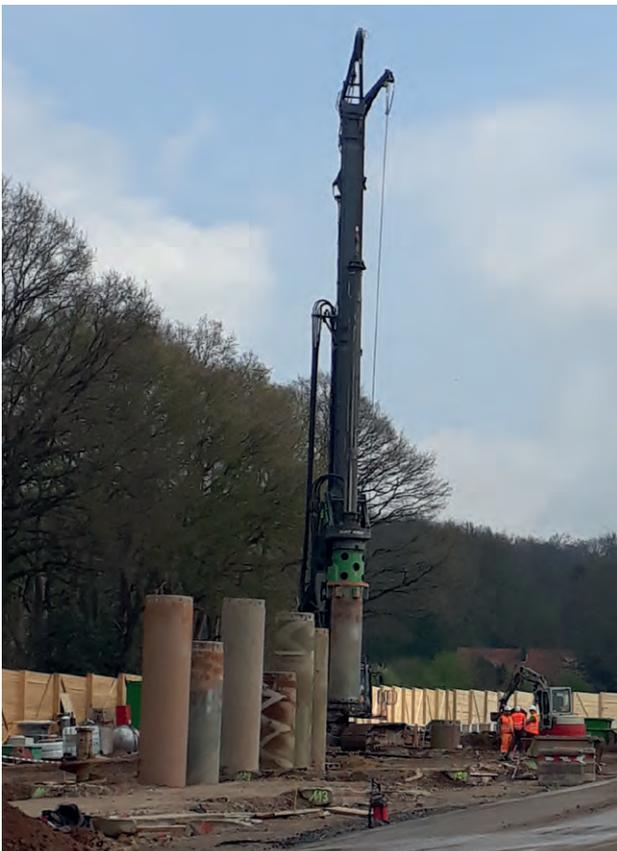
**Bild 6.8** – Drehbohrgerät (Quelle: BR Arnsberg)
