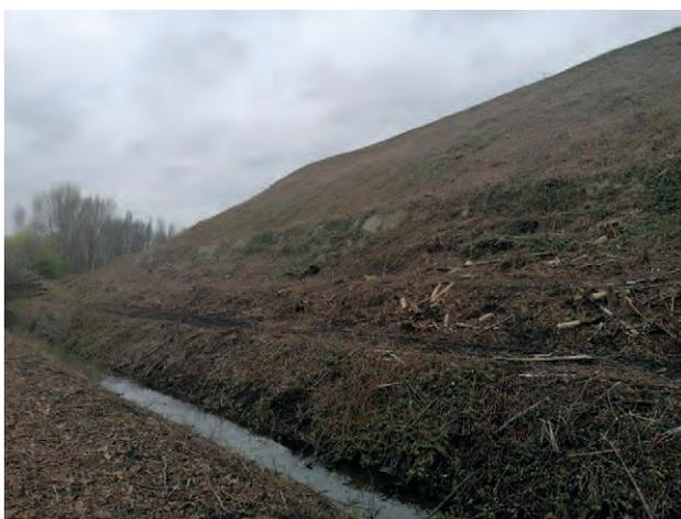
**Bild 9.10** – Zu verrohrender Mühlenbach und freigeschnittene Böschung
