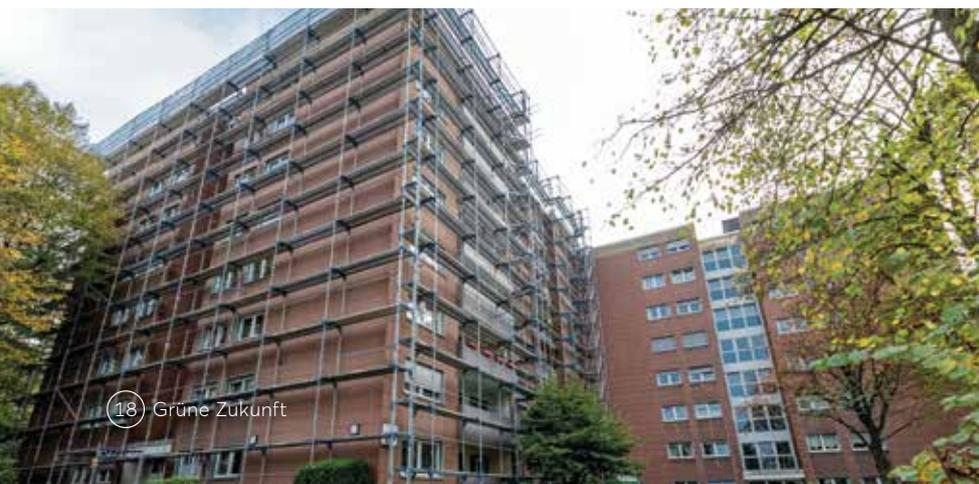
An der Ecke **Aktienstraße 26/Bergische Straße 14** gehen die Arbeiten gerade im Innenbereich weiter. Nachdem dieses Jahr das Haus ein neues Dach und auch eine neue Außenfassade mit Dämmung bekommen hat, werden die Bereiche Elektrik, Sanitär, Fenster, Heizungsanlagen und Brandschutz angegangen, es folgen neue Oberböden.
