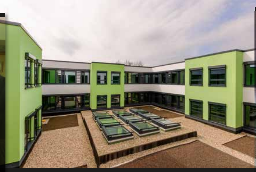
12.09.2022 – Erweiterungsbau der Gesamtschule Norf
