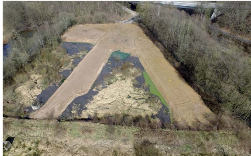
Schlammflächen in Kohlfurth
