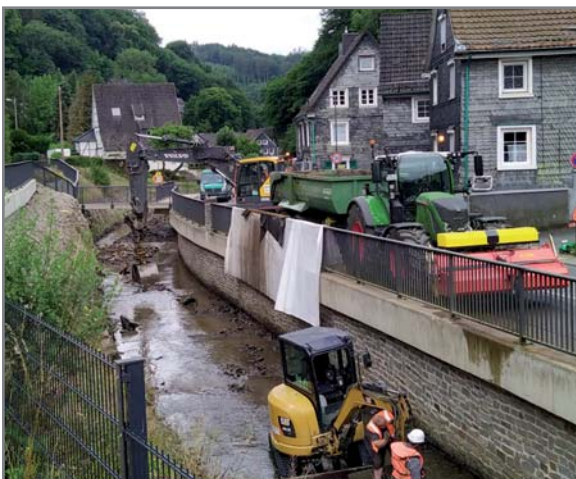
Schotterräumung am Eschbach
