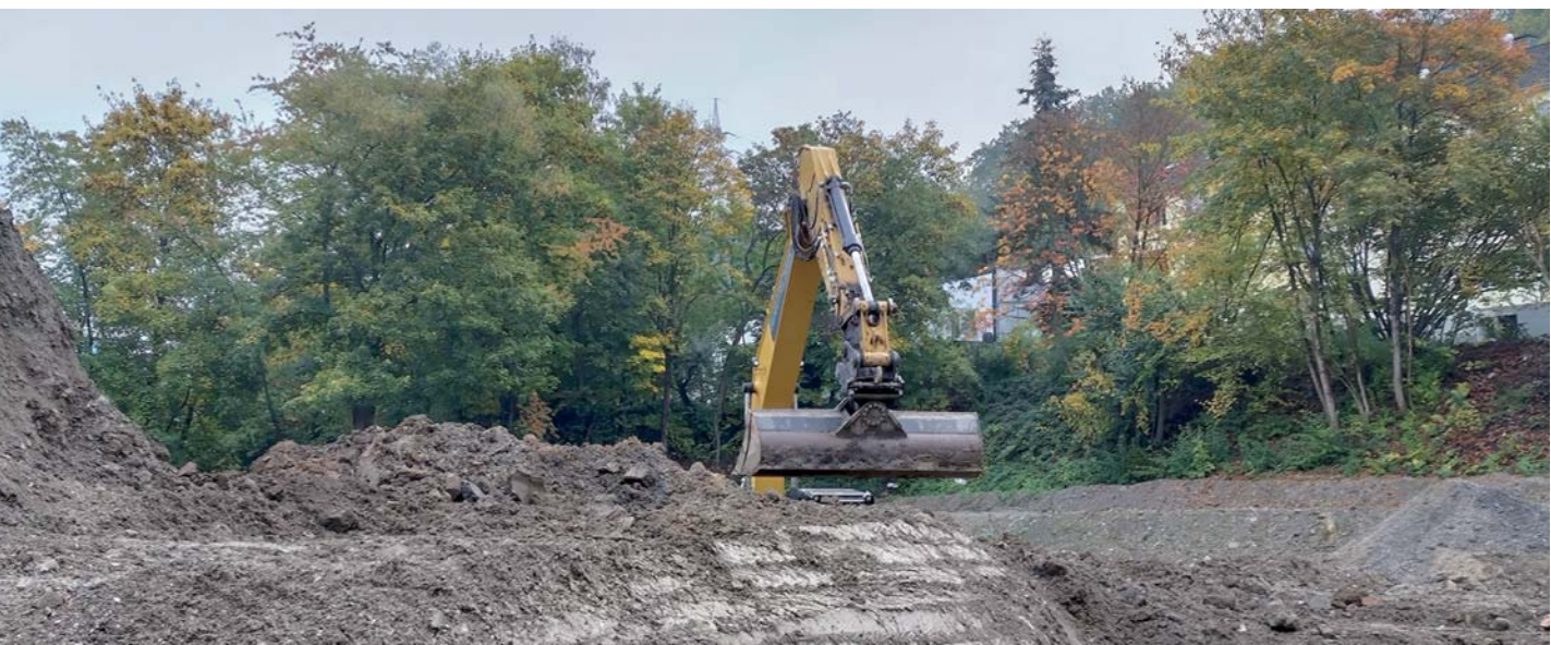
HRB/RRB Bornberg, Baubeginn
