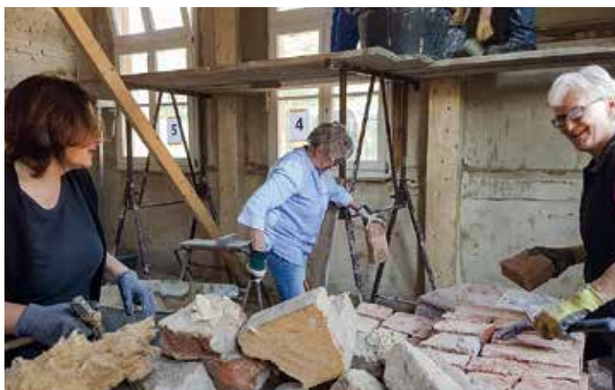
Neben handwerklichen Fachbetrieben waren bei der Sanierung auch viele freiwillige Hände im Einsatz.
