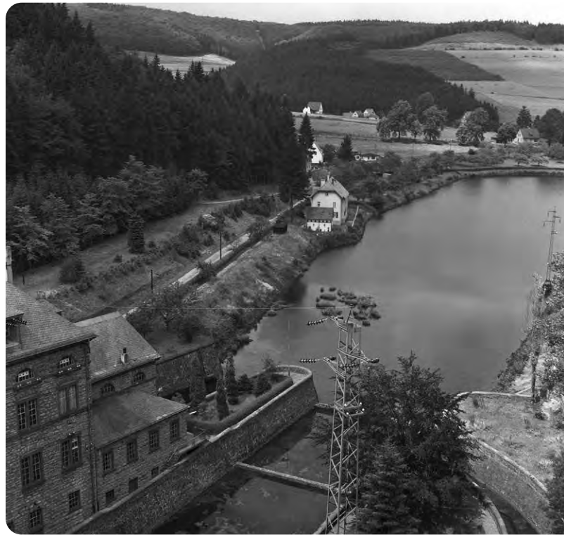
Diemelsee, Kraftwerk an der Talsperre bei Marsberg-Helminghausen, Juli 1960
