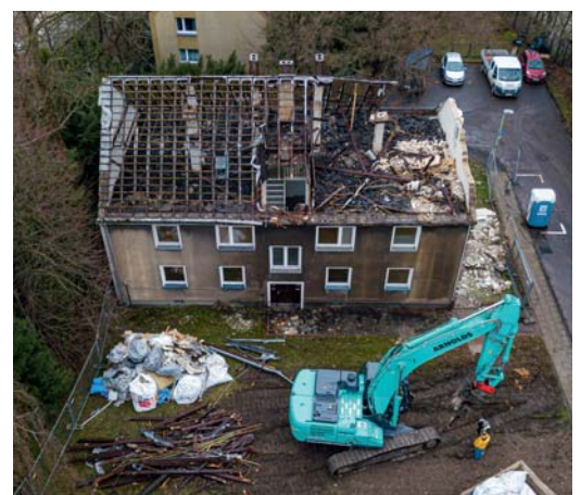
Die Häuser im ersten Bauabschnitt wurden bereits abgerissen.
