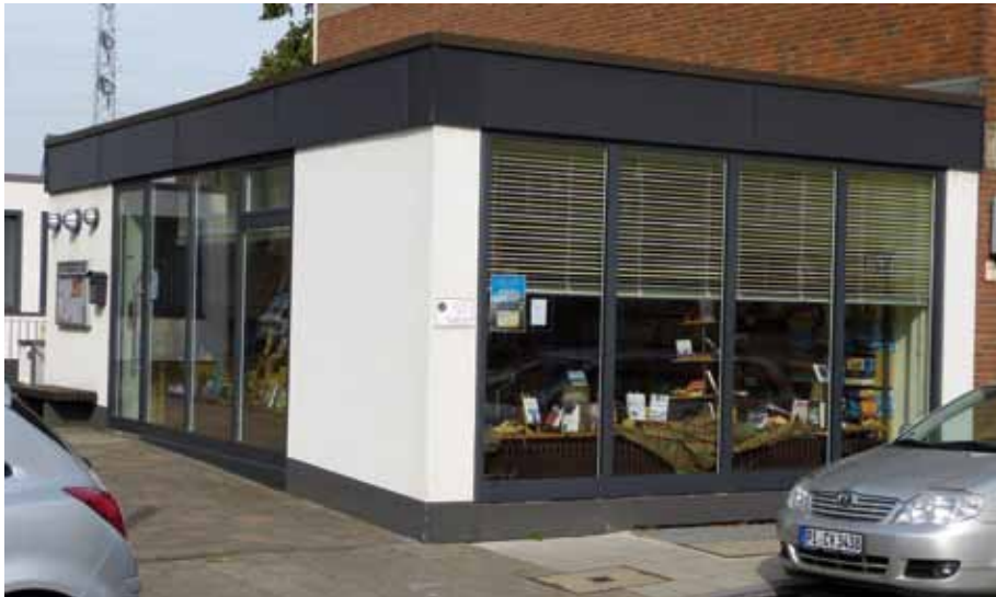
Außenansicht der Bücherei in Hamm
