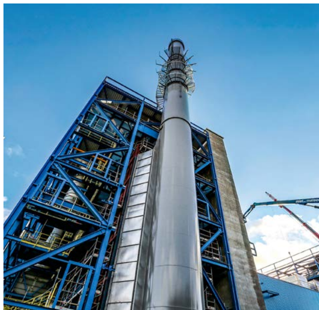
Bau des neuen GuD-Kraftwerks in Marl.
