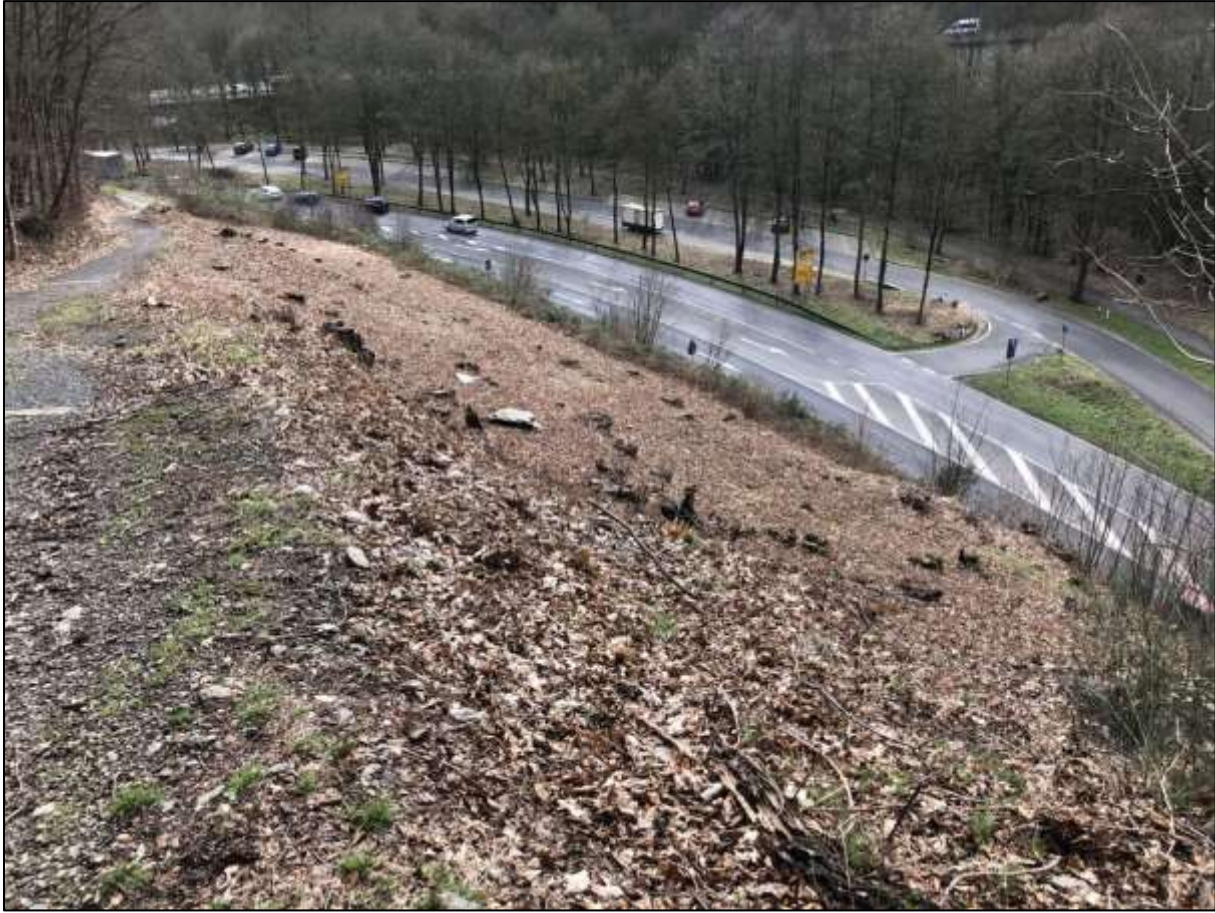
Abb. 39: Im Februar 2020 freigestellte Hangfläche an der L 74 nahe des Felssporns Müngsten (Foto vom 21.02.2020, BSMW, Boomers)
