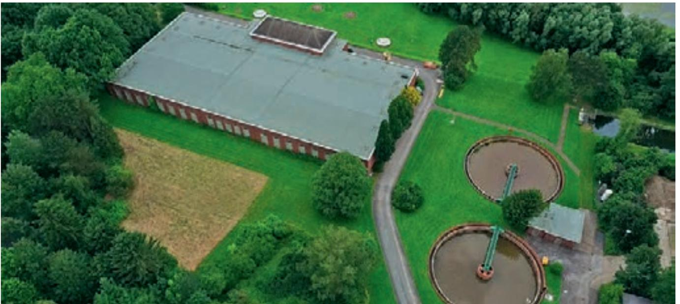
Bild 19.1: Die Schnellfilterhalle und die Absetzbecken der Wassergewinnung Essen-Burgaltendorf
