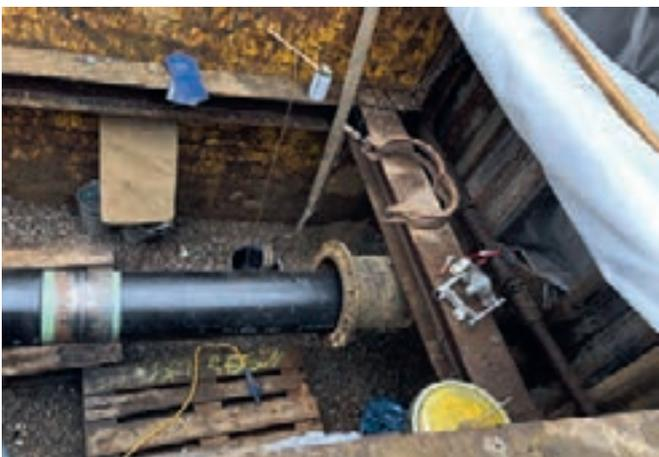
Bild 17.6: Rohreinzugsverfahren in Mengede. Die Anbindungsleitung errichtete die Gelsenwasser AG.
