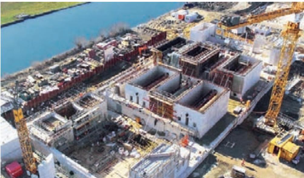
Bild 18.7: Rohbauerstellung der weitergehenden Aufbereitungsanlage
