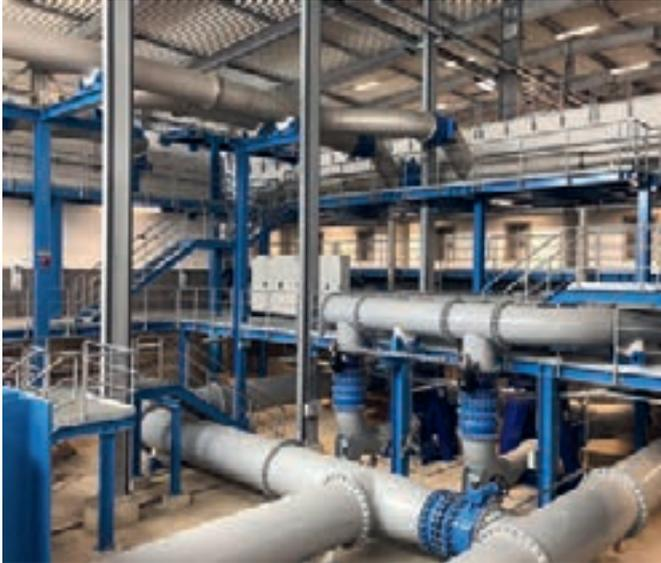
Bild 18.4: Rohrleitungskeller, Ozonreaktoren und Schnellfilter mit darunter liegenden Reinwasserbehältern
