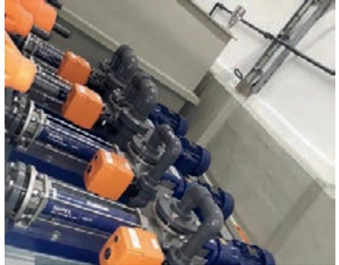
Bild 19.6: Exzenterschneckenpumpen zur Förderung der Dosierlösung
