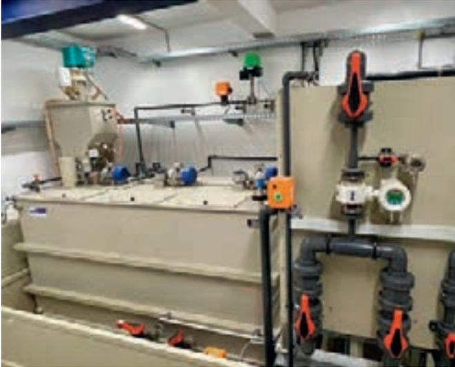
Bild 19.5: 3-Kammer-Durchlaufanlage zur Aufbereitung der Dosierlösung
