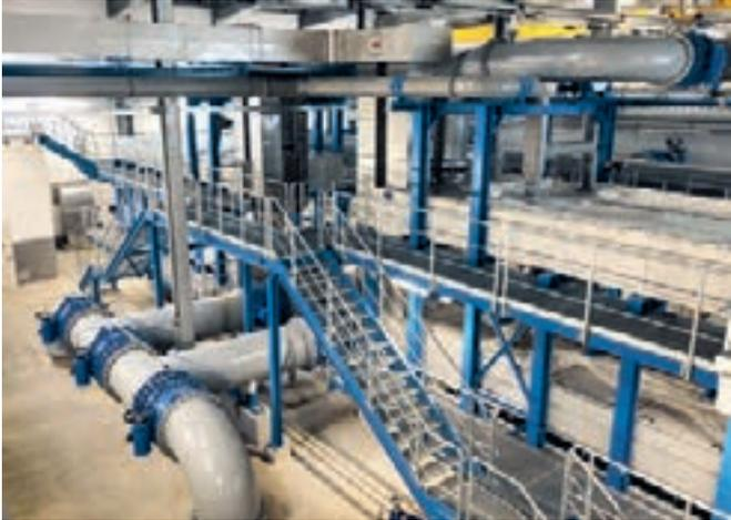
Bild 18. 6: Physikalische Entsäuerungsanlage in Doppelstockbauweise
