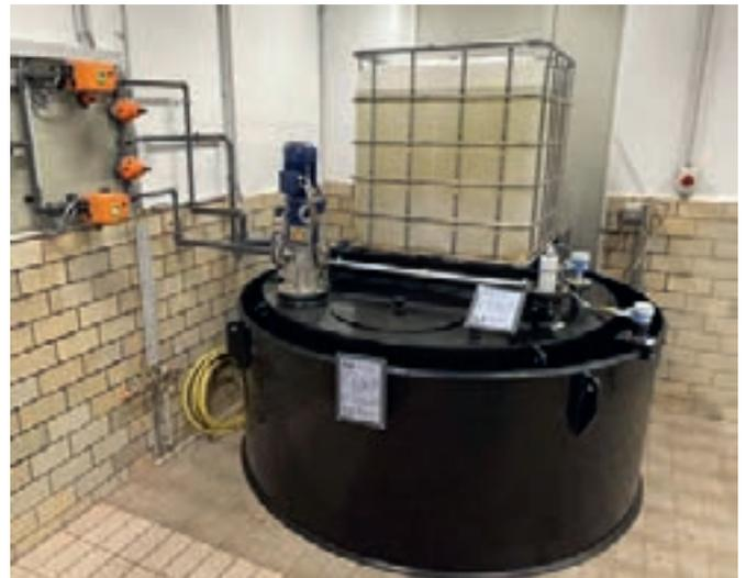
Bild 19.7: Mutterbehälter als Lagerbehälter für das Stärkekonzentrat
