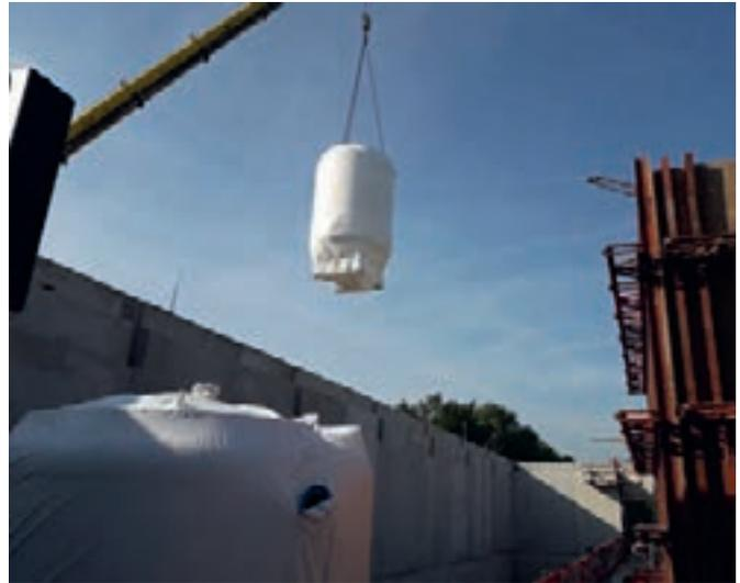
Bild 18.12: Lieferung und Positionierung eines Aktivkohlefilters, Mai 2019
