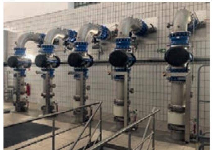
Bild 18.3: Mitteldruck-UV-Anlagen im Maschinenhaus des Netzpumpwerks
