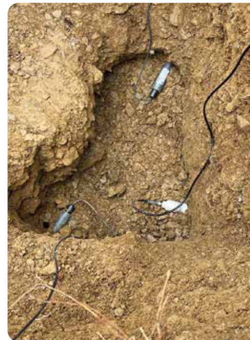
Einbau von Bodenfeuchtemesssonden auf der Level-II-Fläche Elberndorf
