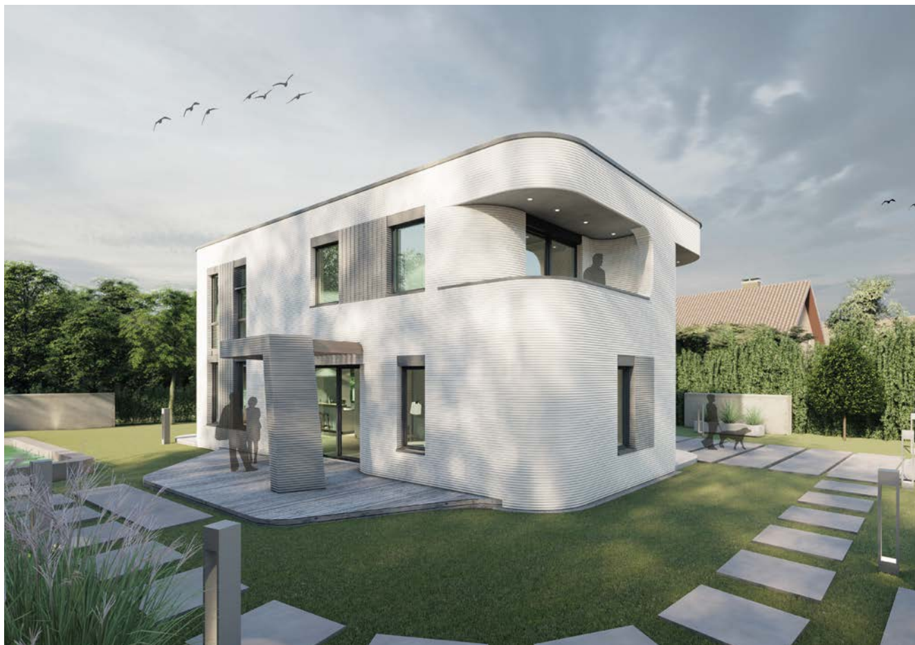
Animation des deutschlandweit ersten Wohnhauses, das mittels des 3D-Druck-Verfahrens in Nordrhein-Westfalen realisiert wurde. Es handelt sich um ein zweigeschossiges Einfamilienhaus mit etwa 80 Quadratmetern Wohnfläche pro Etage. Das Projekt wurde vom Ministerium für Heimat, Kommunales, Bau und Gleichstellung des Landes Nordrhein-Westfalen gefördert.
