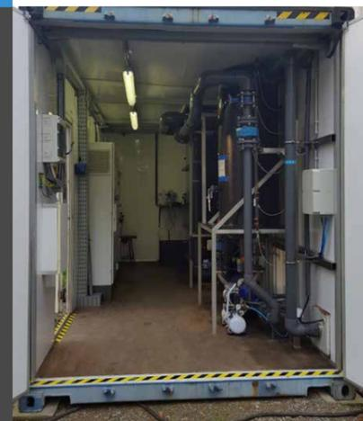
Blick in den Container mit der Membran-Batch-Reaktor (MBR)-Anlage
