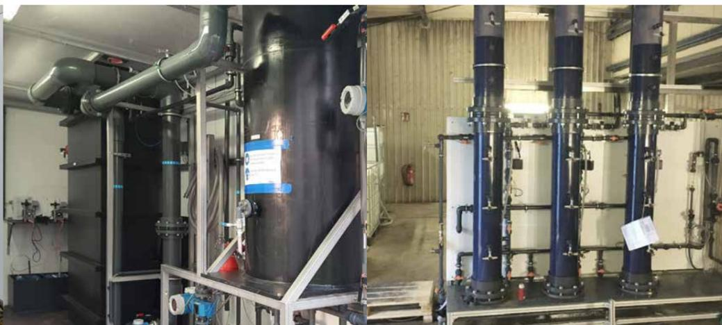
Granulierte Aktivkohle (GAK)-Filteranlage mit drei parallelen Aktivkohle-Säulen in der Filterhalle
