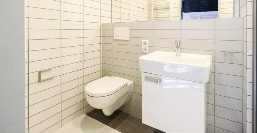
General-Weber-Kaserne in Höxter: Sofort nach dem Anschluss an die Versorgungsleitungen des Gebäudes ist die vorgefertigte Sanitärzelle einsatzbereit.
