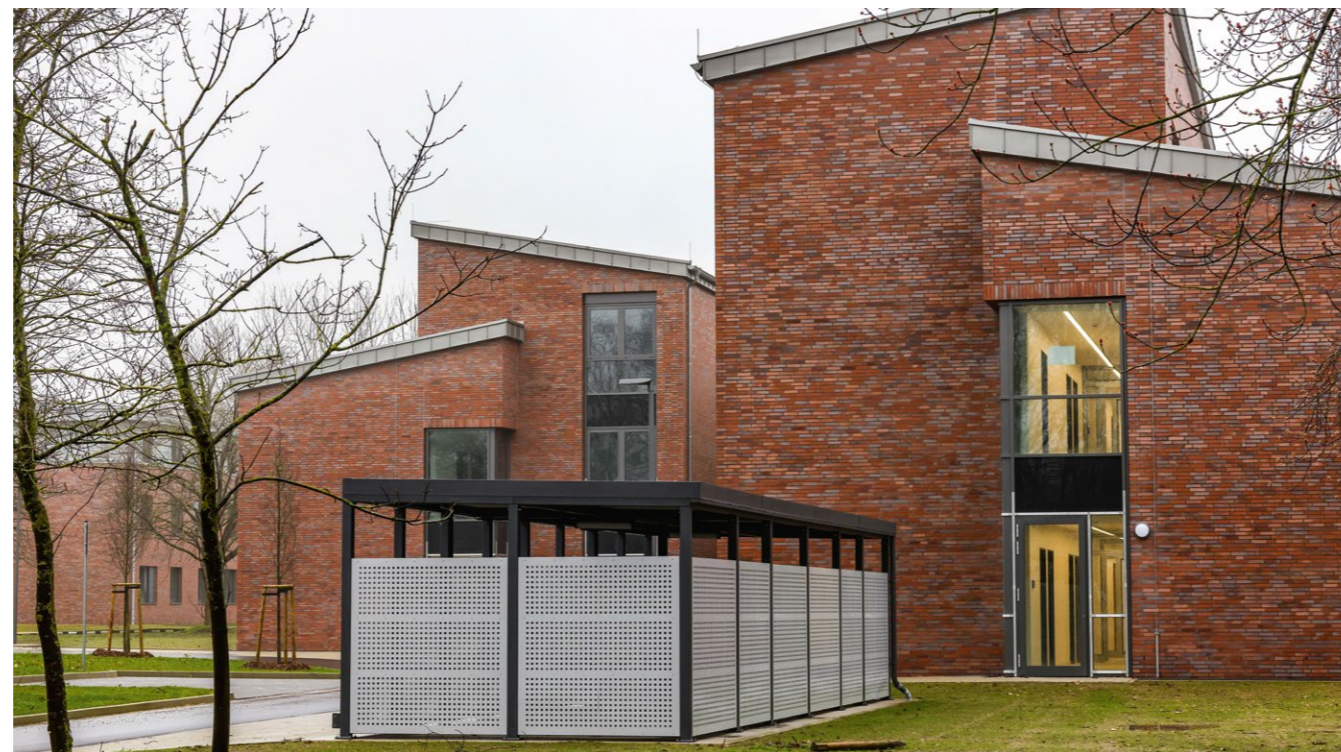
Die neuen Unterkunftsgebäude erfüllen die aktuellen Standards der Bundeswehr und gliedern sich mit ihrer roten Klinkerfassade gut in die Kaserne ein.
