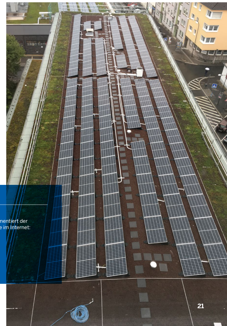
Die kühlende Wirkung der extensiven Dachbegrünung erhöht den Wirkungsgrad der 130 Solarmodule auf dem Finanzamt Wuppertal-Barmen.
