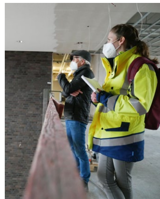
Durch die große Fensterfront im gerade entstehenden Neubau hat man einen tollen Blick über die Kaserne am Paulsberg.
