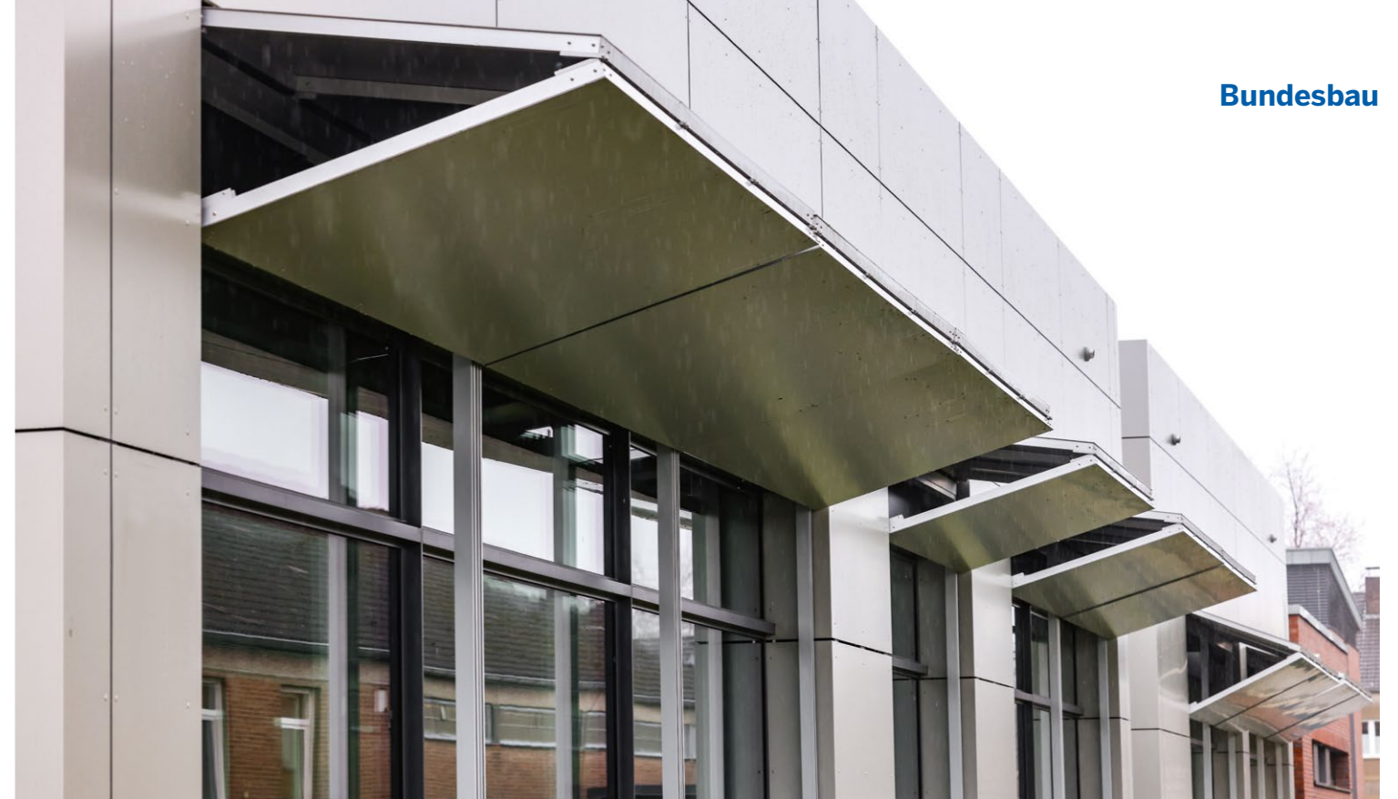
Die Sonnenschutzklappen passen sich optisch vollkommen an die restliche Fassade an, wenn sie geschlossen sind.
