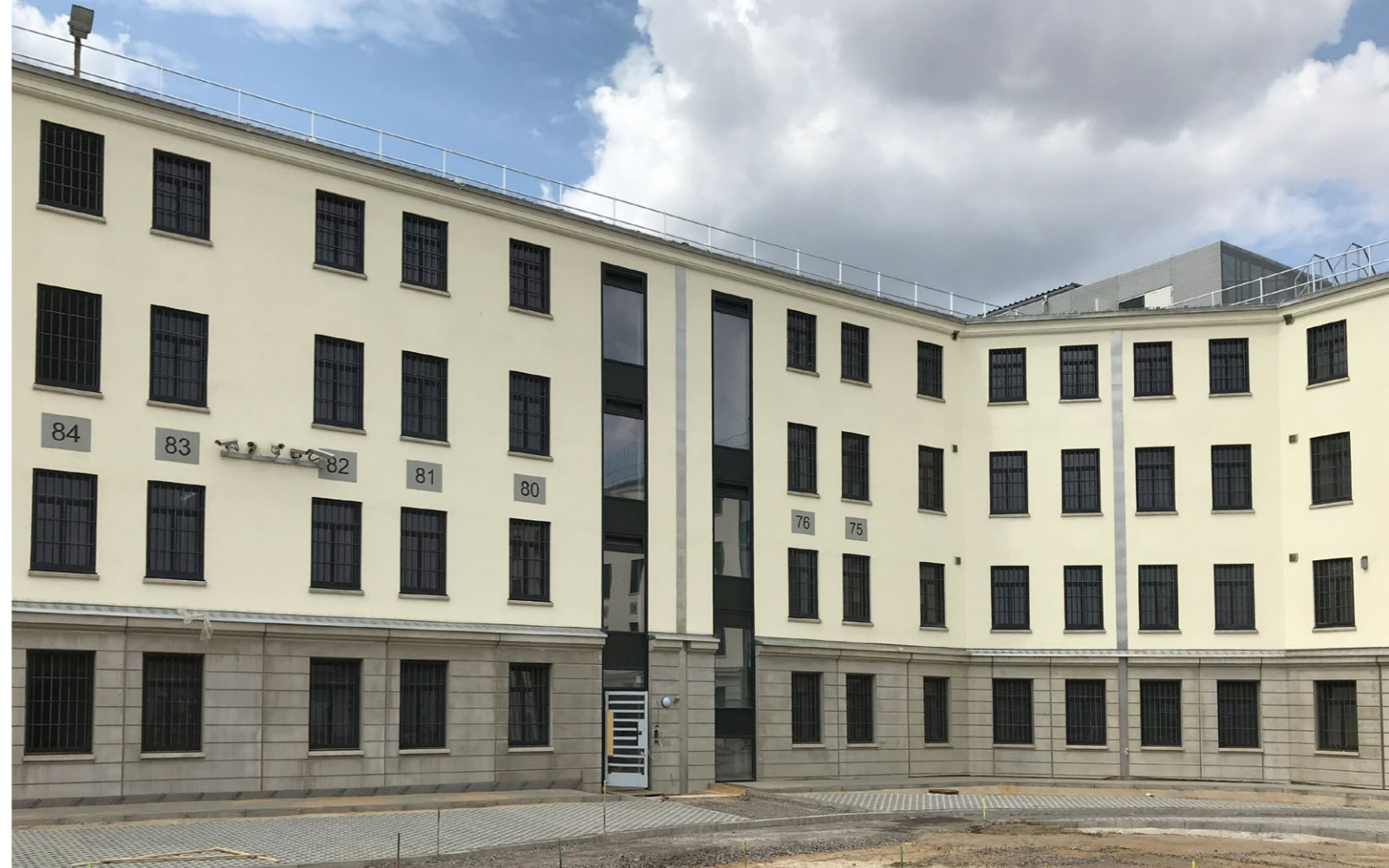
Das neue Hafthaus C kurz vor der Fertigstellung.
