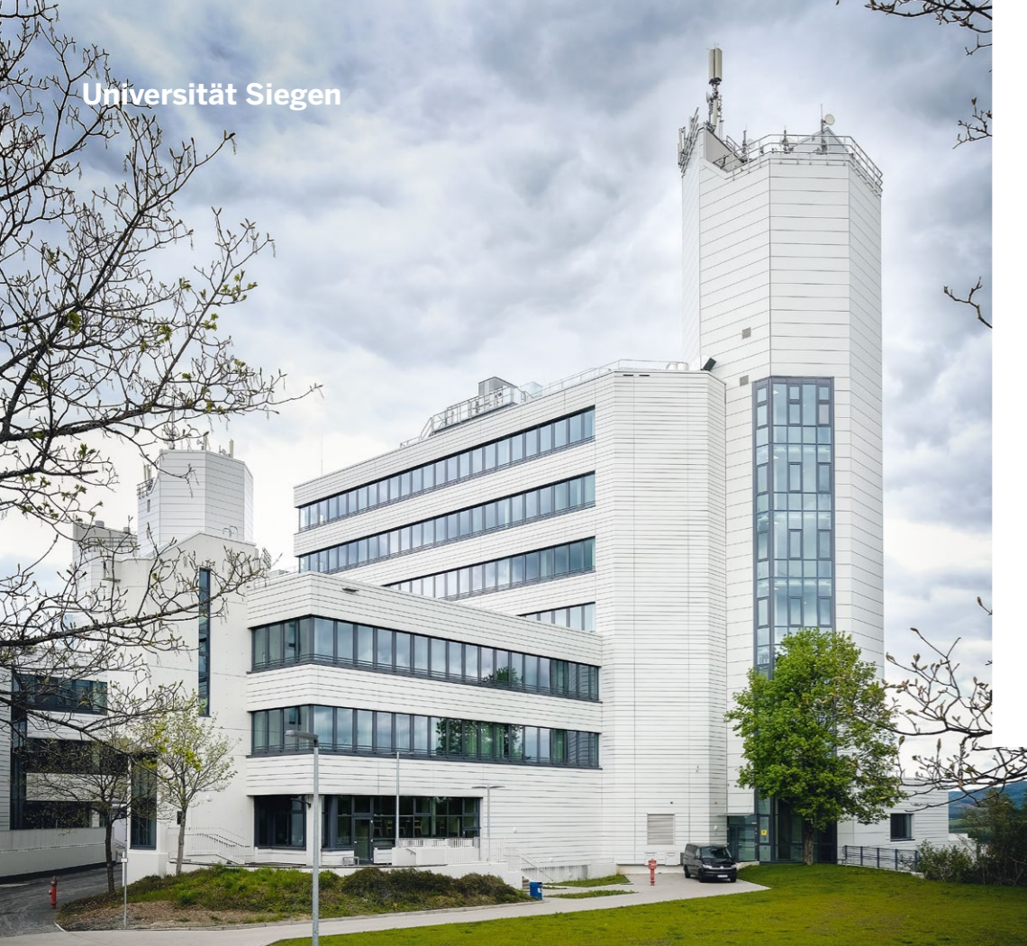
Hell und energiesparend – die neue Außenfassade der modernisierten Gebäude besteht aus rund 25.000 einzelnen Aluminiumblech-Elementen.
