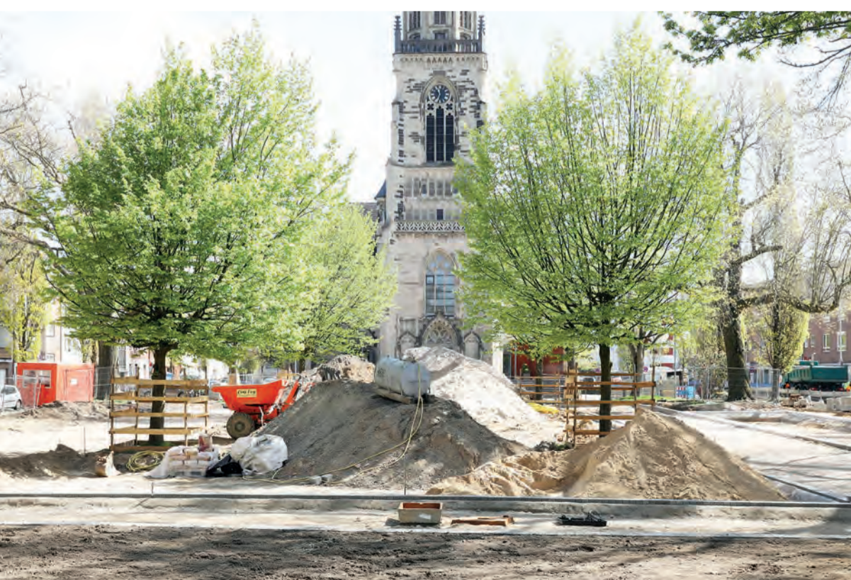
Die Neugestaltung des Keplerplatzes in Rheydt liegt auf Zielgeraden.
