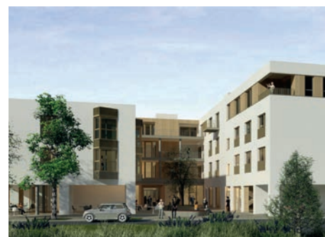
In Norf entsteht ein Pflegezentrum mit Seniorenheim
