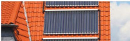
Die Sonne ist ein Wärmespender. So wird Wasser in einem Gartenschlauch, der in der Sonne liegt, erwärmt, und zwar in einem dunklen Schlauch stärker als in einem hellen. Dieses Grundprinzip wird in der Solarthermie zur direkten Erzeugung von Wärme genutzt. Diese Wärme kann zur Erzeugung von warmen Brauchwasser für Küche und Bad und zur Unterstützung des Heizkreislaufs verwendet werden.
