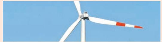
Eine Windkraftanlage wandelt die kinetische Energie des Windes in elektrische Energie um und speist sie in das Stromnetz ein. Moderne Windkraftanlagen besitzen Rotorblätter mit aerodynamisch ausgeprägtem Profil. Ähnlich wie bei Flugzeugen wird der Druckunterschied, der aus den unterschiedlichen Geschwindigkeiten zwischen Saug- und Druckseite des Flügels herrührt, genutzt. Dieser Auftrieb wird in ein Drehmoment und in Drehzahl zum Antrieb des Generators zur Stromerzeugung umgesetzt.
