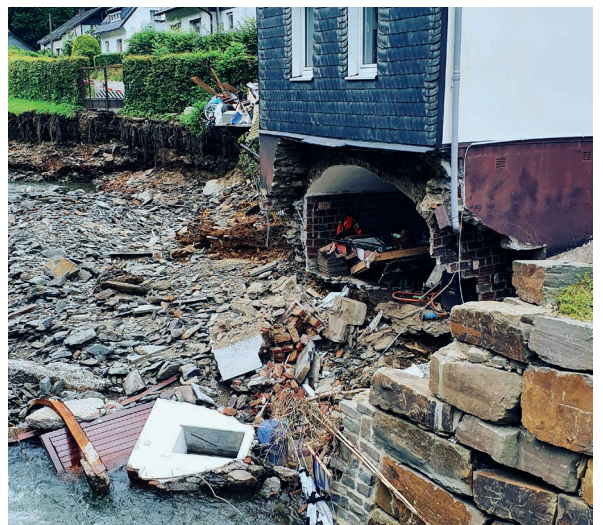
▲ In Solingen-Unterburg hat der Eschbach ganze Hausteile mitgerissen.
