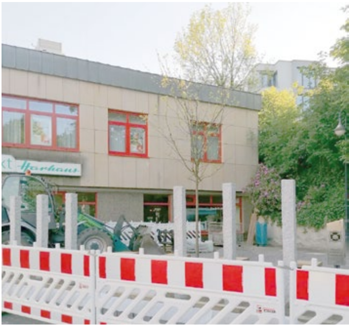
Noch ist Baustelle an der Kölner Straße angesagt. Doch gibt es bereits eine Ahnung vom späteren Erscheinungsbild des neuen Jakobusplatzes.
