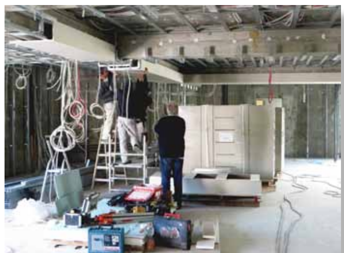
Installationsarbeiten im Innenbereich
